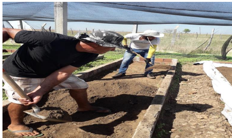
Figura 4. Processo de construção dos canteiros econômicos em água, Sousa/PB, 2018.
