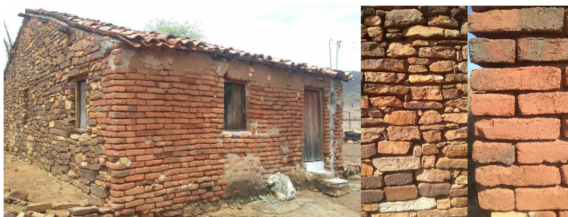
Figura 02: Vista da Casa de pedra : fachada principal e detalhes da alvenaria de pedra e de tijolo cozido.
