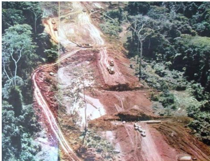
Figura 3 – Trecho da área para terraplanagem na BR-319
