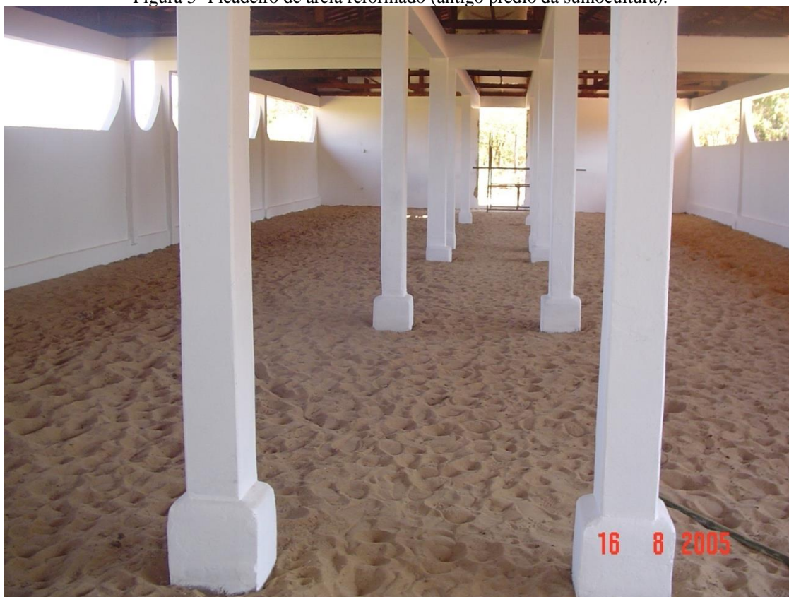
Figura 3- Picadeiro de areia reformado (antigo prédio da suinocultura).
