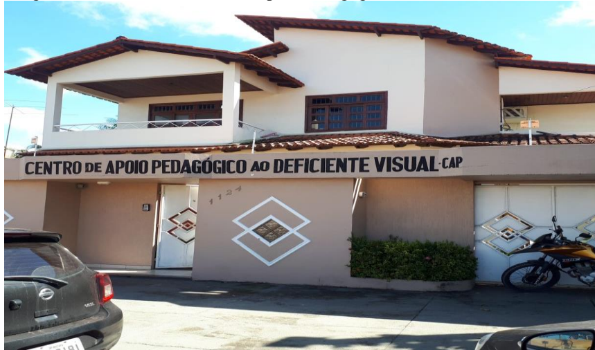
Imagem 1: Fachada do Centro de Apoio Pedagógico Ao Deficiente Visual - CAP
