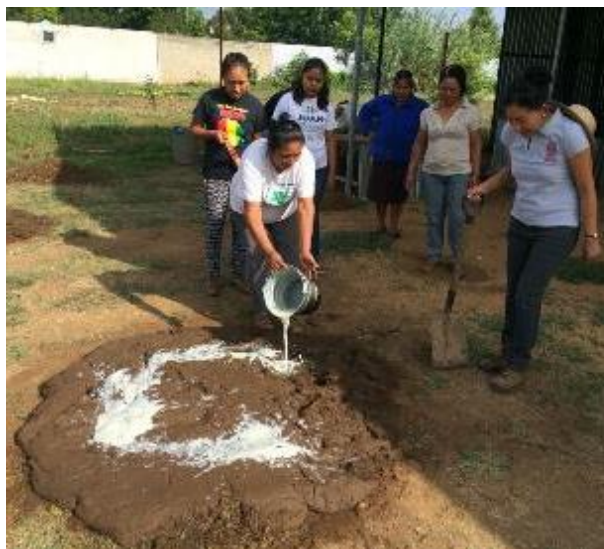
Figura 7.- Transferencia de tecnología mezclas y agregados (a) y Mujeres en la preparación de mezclas para pisos de tierra (b)Tianguis “Gadoo Gush”. San Raymundo Jalpan, Oax. Fuente: OSC, 2018.
