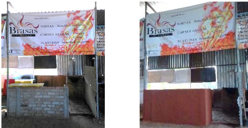
Figuras 1 Vista del local antes de la intervención (a) y con la aplicación de Ecotécnia aplanado con tierra en barra de local (b), Tianguis “Gadoo Gush”, San Raymundo Jalpan, Oax. Fuente: OSC 2018.
