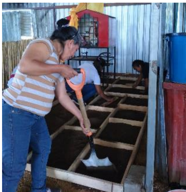
Figura 8.- Participantes del taller en el colado de piso de tierra Tianguis “Gadoo Gush” San Raymundo Jalpan, Oax. Fuente: OSC, 2018.
