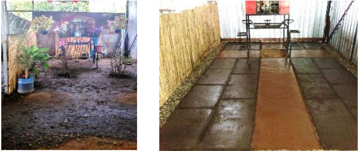
Figura 9.- Vista de la capilla del tianguis “Gadoo Gush”, previo a la intervención constructiva del taller pisos con tierra (a) y Piso terminado en el taller constructivo “Pisos de tierra” (b). Fuente: OSC, 2018.
