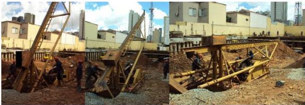
Figura 5 – Torre do bate-estaca depois de desacoplada sendo deitada
