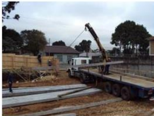
Figura 3 - Descarregamento da estaca pré-moldada
