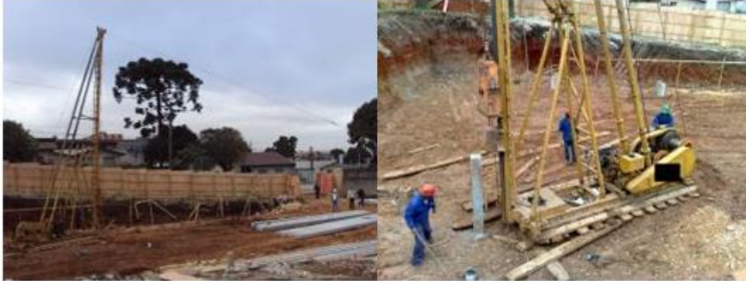
Figura 2 – Deslocamento do equipamento
