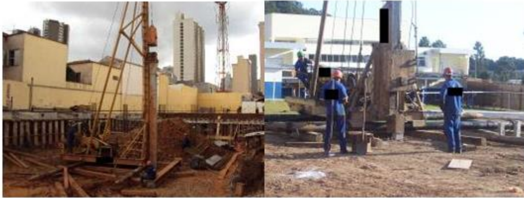
Figura 4 – Processo de Cravação da Estaca
