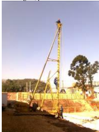
Figura 1 – Montagem, posicionamento dos cabos de aço
