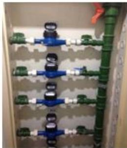
Figura 5-Hidrômetros de água da chuva.
