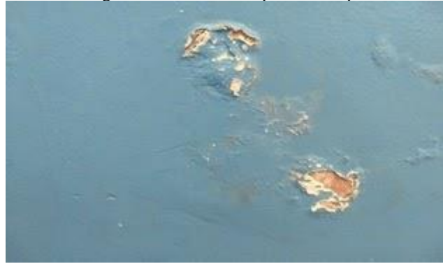
Imagem 11 – Bolhas nas paredes do pátio
