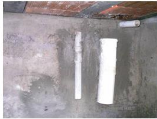
Fig.04: Tanque séptico secundário, saída final do último tanque com cano para coleta do efluente final.
