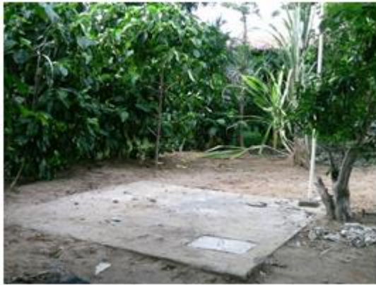
Figura 01: Tanque séptico principal com volume de de aproximadamente 6m 3 cada.
